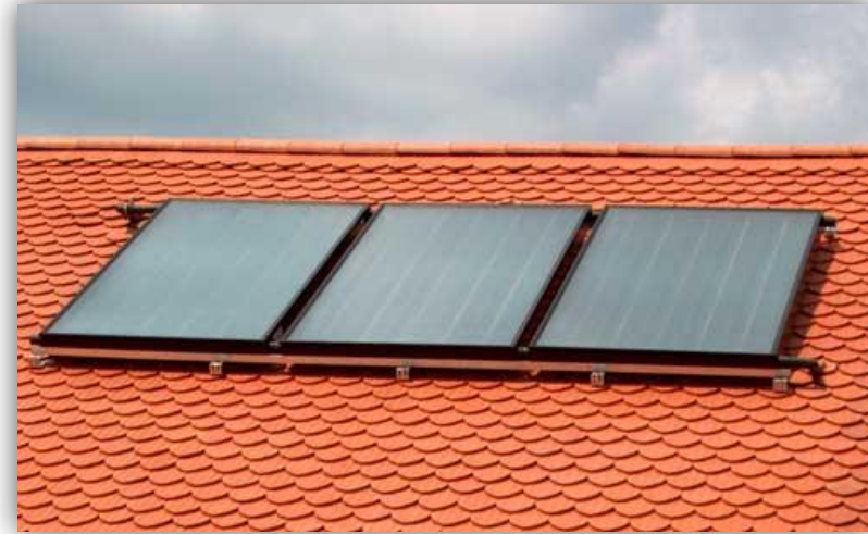
napelem elhelyezése hagyományos hódfarkú cserépfedésen
