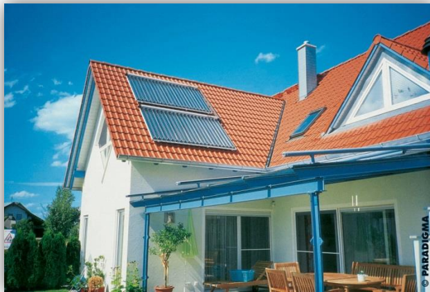
napkollektor elhelyezése belső (udvarra néző) tetőfelületen
