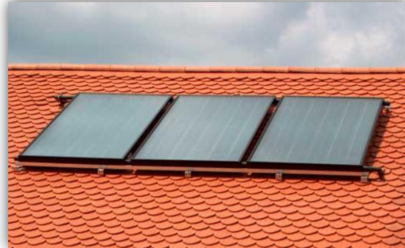
napelem elhelyezése hagyományos hódfarkú cserépfedésen
